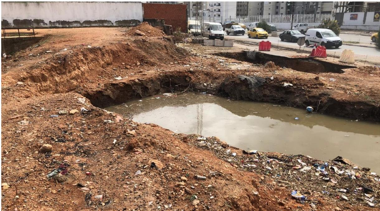
*Photo 28: travaux de raccordement du bassin de rétention des eaux pluviales au canal principal sur la N7*
